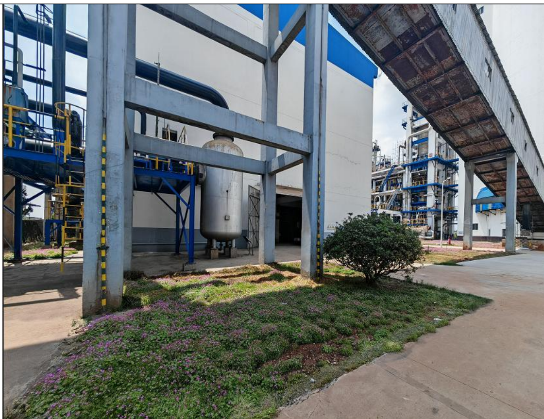
图 F1-6 项目西南面-压缩厂房
