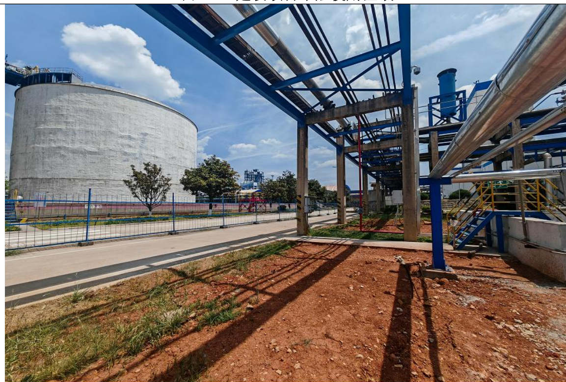
图 F1-5 建设项目东北面-氨储存区
