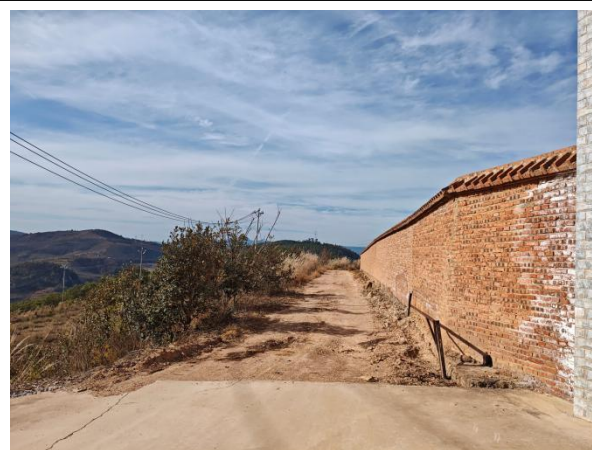
站区西侧围墙
