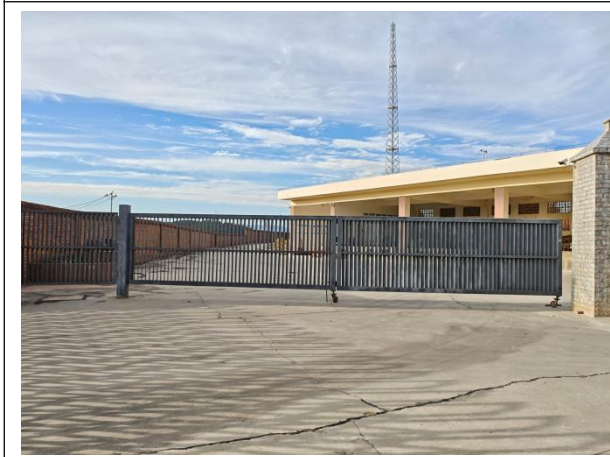
罐区和充装区二道门
