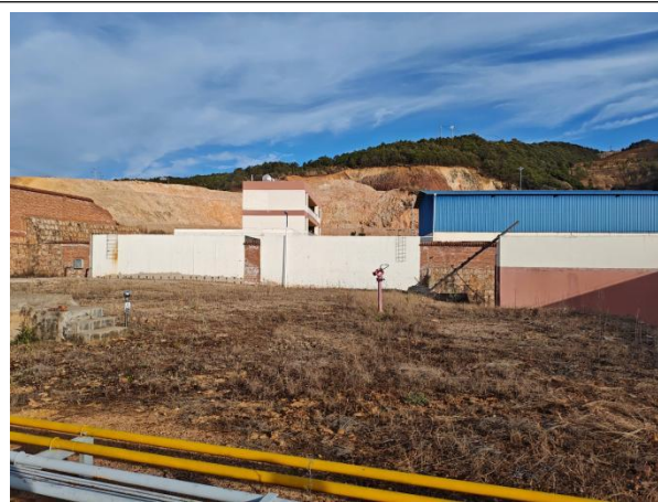
罐区消防水炮
