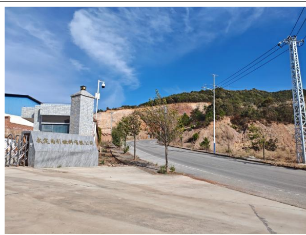
储配站东南侧园区道路
