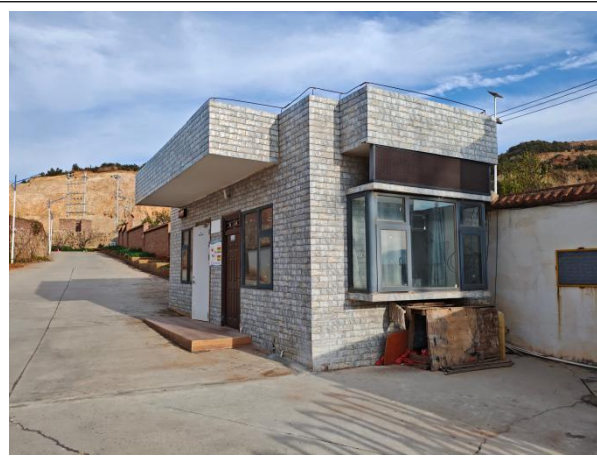
门卫室及监控室
